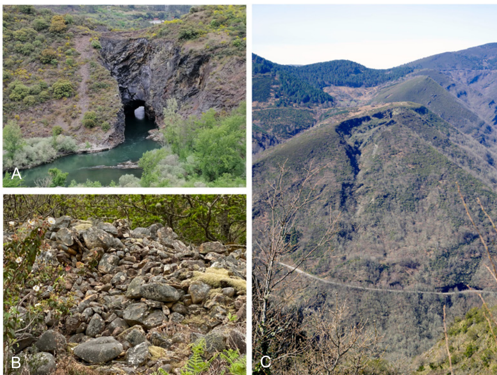
Figura 2. A minería romana do ouro. A) A obra de enxeñaría de Monte furado é o mellor exemplo do impacto que a explotación do ouro secundario tivo nesta comarca; a canle do río Sil foi desviado para liberar os sedimentos e poder beneficiar o ouro sedimentario. B) As murias na parroquia de Figueiredo (Ribas de Sil,) son tamén outro exemplo. C) Por outra banda, no concello de Folgoso foi beneficiado o ouro primario. Na mina da Toca aínda é perfectamente visible a cicatriz que deixou o dismantelamento dun gran filón de cuarzo.
